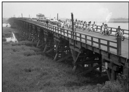
堀切橋に差し掛かるランナー
